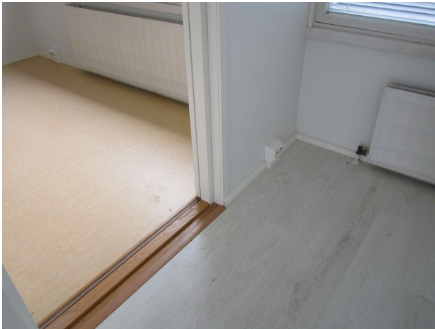
20- olohuone, ilmaisu ulkoseinän lattiaanrajaan (patteriputket)
