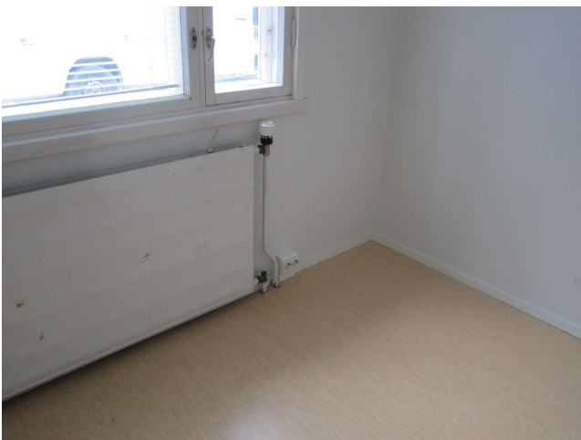
36- huone4, ilmaisu ulkoseinän lattiaanrajaan (patteriputket)
