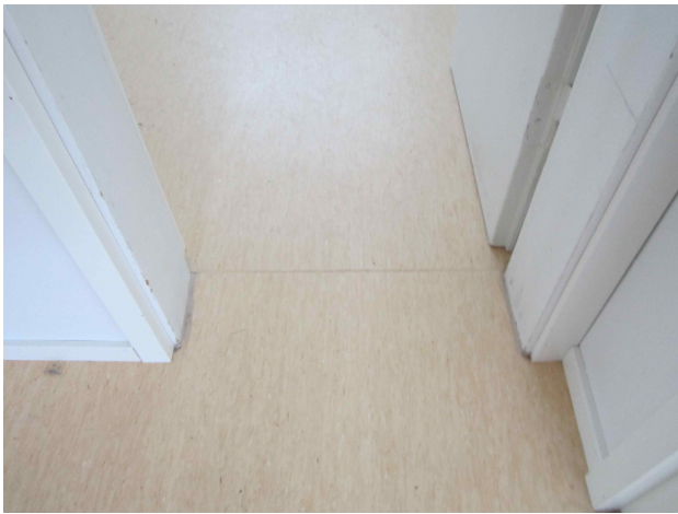
27- komero, ilmaisu ovenkarmin reunaan lattiaan
