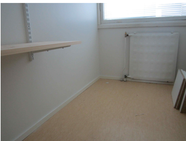
28- komero, ilmaisu väliseinän lattianrajaan
