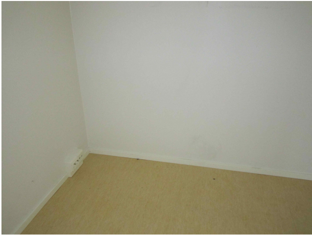
5- huone2, ilmaisu ulkoseinän lattianrajaan (pistorasia lähellä)
