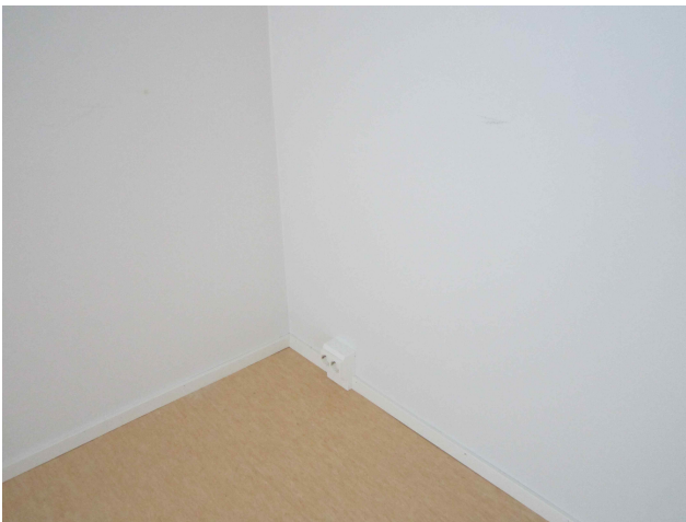
32- huone3, ilmaisu ulkonurkkaan lattianrajaan (pistorasia)
