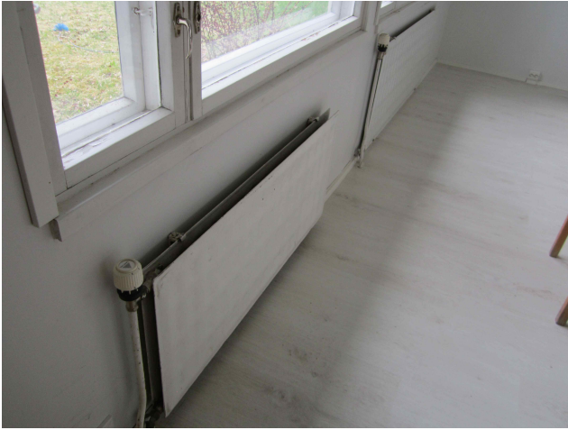
15- keittiö, ilmaisu ulkoseinän lattianrajaan (patteriputket)
