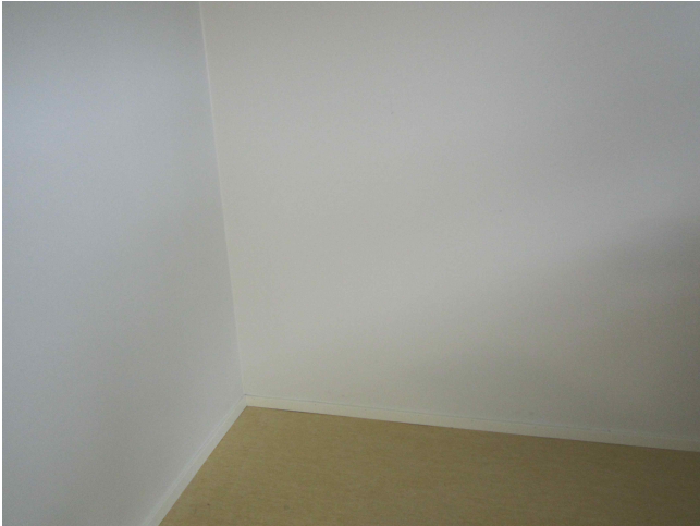
4- huone2, ilmaisu ulkoseinän lattianrajaan
