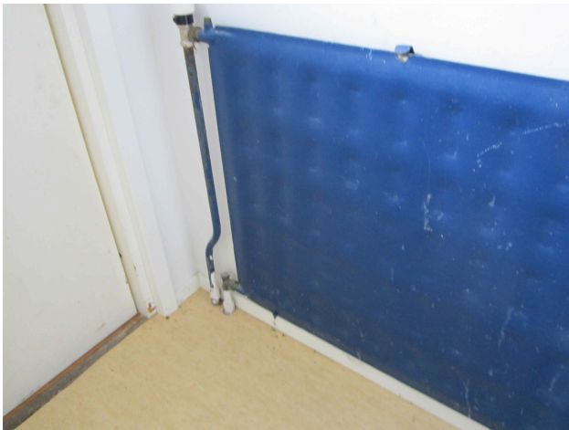
25- tuulikaappi, ilmaisu väliseinän lattiaanrajaan (patteriputket)
