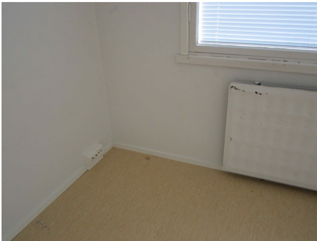
35- huone4, ilmaisu ulkoseinän lattiaanrajaan (pistorasia)
