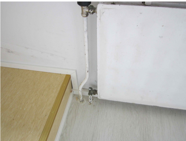
14- keittiö, ilmaisu ulkoseinän lattianrajaan (patteriputket)
